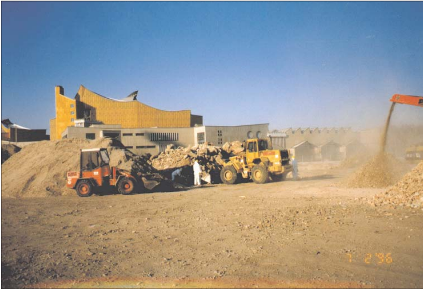
Aufbereitung des kontaminierten Auffüllbodens (mit händischer Separation)
