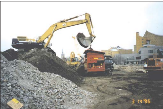
Aufbereitung des kontaminierten Auffüllbodens
