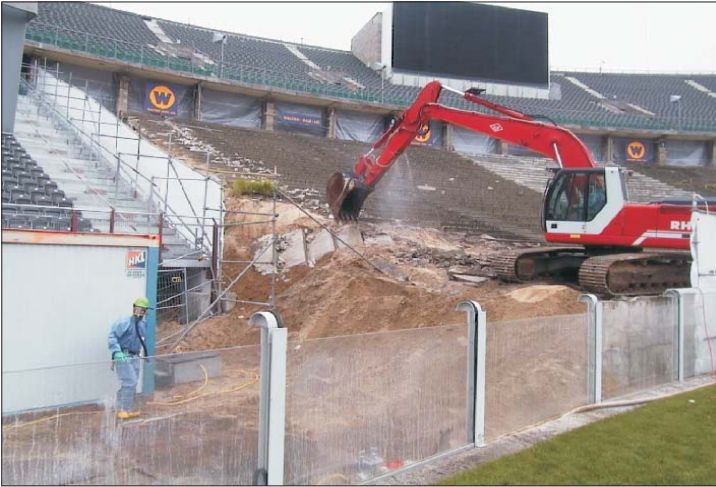
Beginn des Rückbaus der PCB-haltigen Stufen im Unterring
