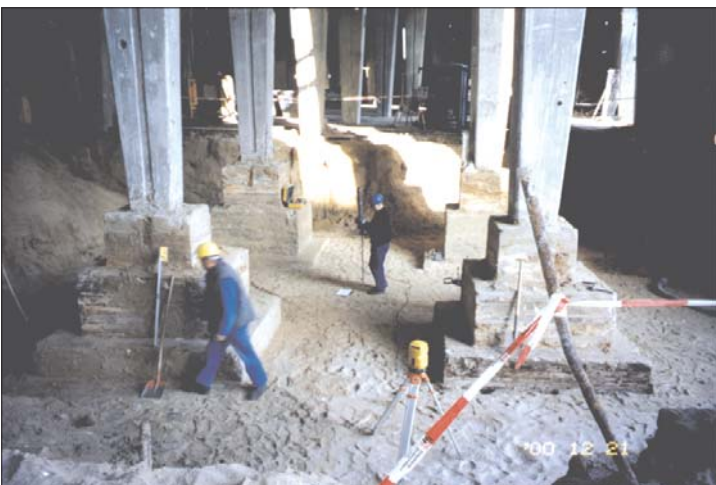
Im Tiefkeller des Olympiastadions: Sohlabnahme an einem Fundament für eine neue Dachstütze
