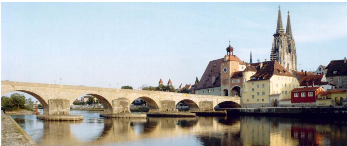
Bild 1: Blick auf die heutige Brücke gegen Süden
